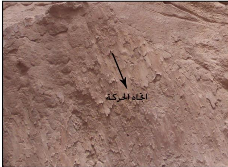
صورة رقم (1 – 1) ظاهرة الحزوز الناتجة بفعل الفوالق، شوهدت في منطقة الدراسة وهي تقع في المحطة رقم (1) الى الجانب الايمن من نهر ديالى ونستنتج منها اتجاه الحركة
